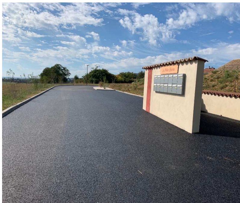
Exemple d'ouvrage maçonné incorporant les boîtes aux lettres Lotissement la petite Bièvre à Gillonnay – réalisation de LEX AEQUO
